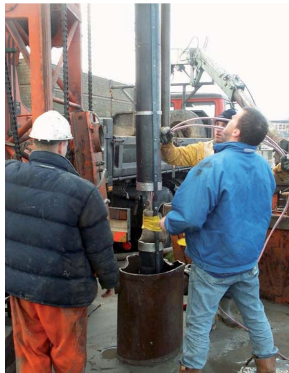
Figuur 4. Voor het plaatsen van dieptebed anodes is het noodzakelijk gaten van 80 - 90 m diep in de zee te boren.
